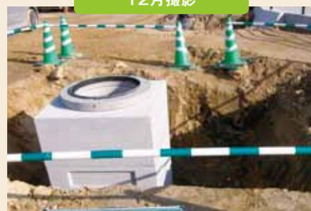
トラロープからカラーコーンにレベルアップしていたが、1ヶ月間昇降設備無しで、型枠・コンクリート作業が行われていた(ケガが無くてよかった)。
